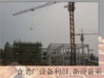
在老厂设备利旧,新设备采购和现场建设阶段,4月下旬完成了年产6万吨甲醛生产装置、年产1万吨乌洛托品装置及其它工段有利旧价值设备的拆除和搬迁工作。8月上旬完成了包括进口催化剂采购、反应器
